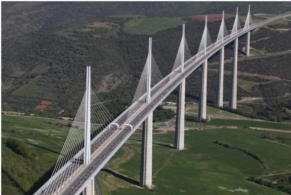
Le viaduc Mai-Août : début du projet (vue depuis le Lundi de Pâques, vers le sud)
